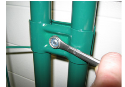
Kiinnityskappale kiinnitetään 13 tai 14 mm:n kiintolenkkiavaimella tai räikällä (pulttien koko on joko 13 tai 14 mm).
